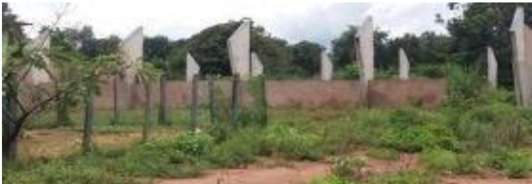
Figura 12 Construção não finalizada (Arquivo Projeto Raios de Sol)
