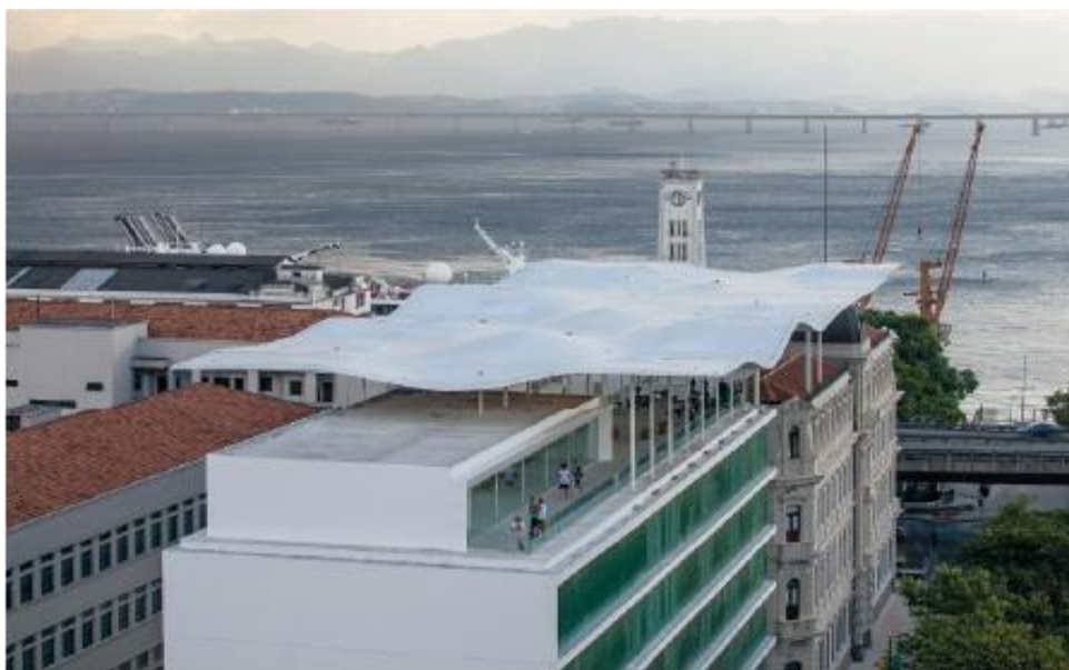
Figura 4 - Vista para a cobertura_MAR.
