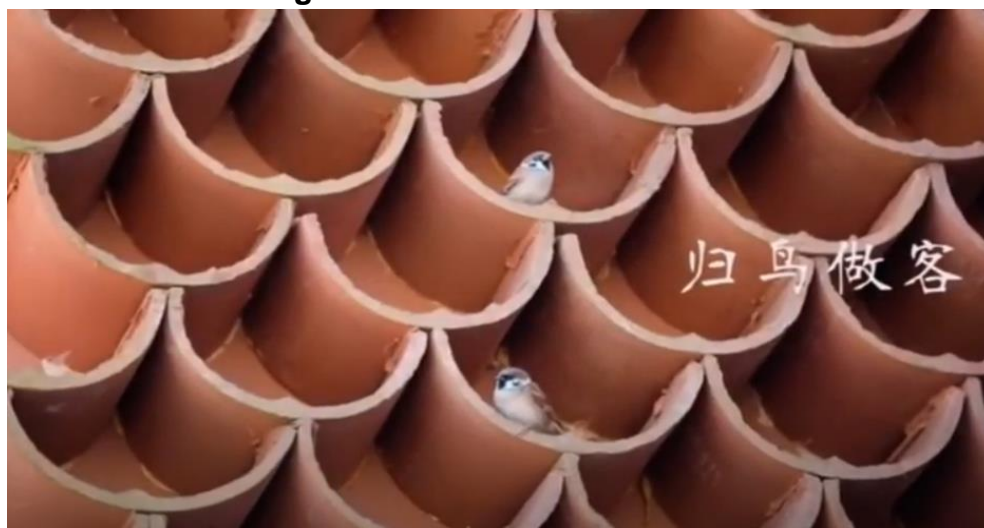
Figura 26 - Detalhe da fachada.
