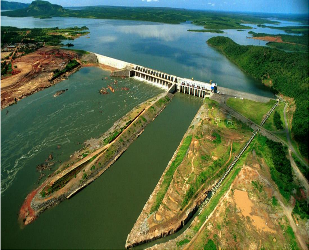
Figura 1: Barragem da UHE Luís Eduardo Magalhães
