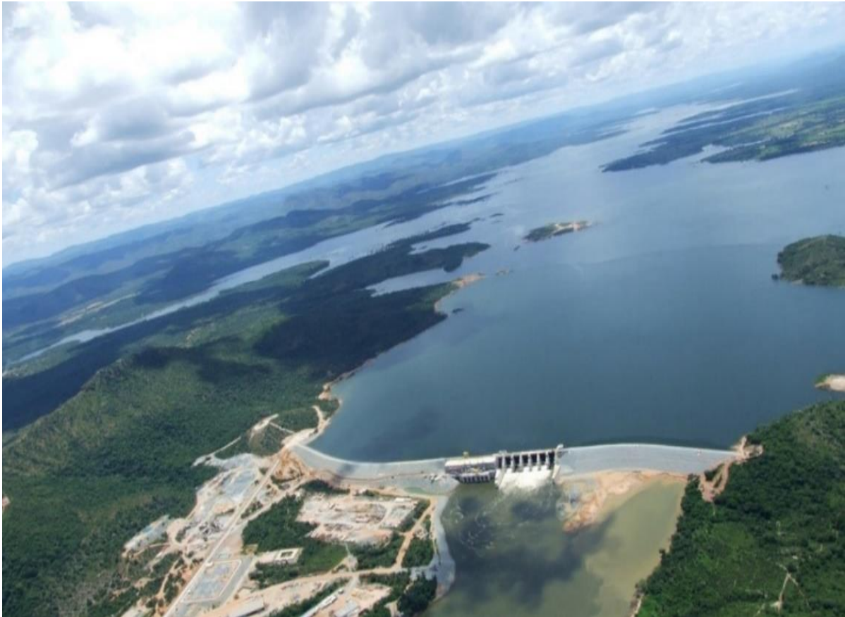
Figura 5: Barragem da UHE São Salvador
