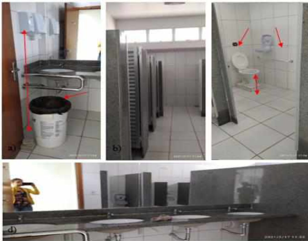
Figura 46 – Trecho D – Complexo de Laboratório de Nutrição – Banheiro Feminino
