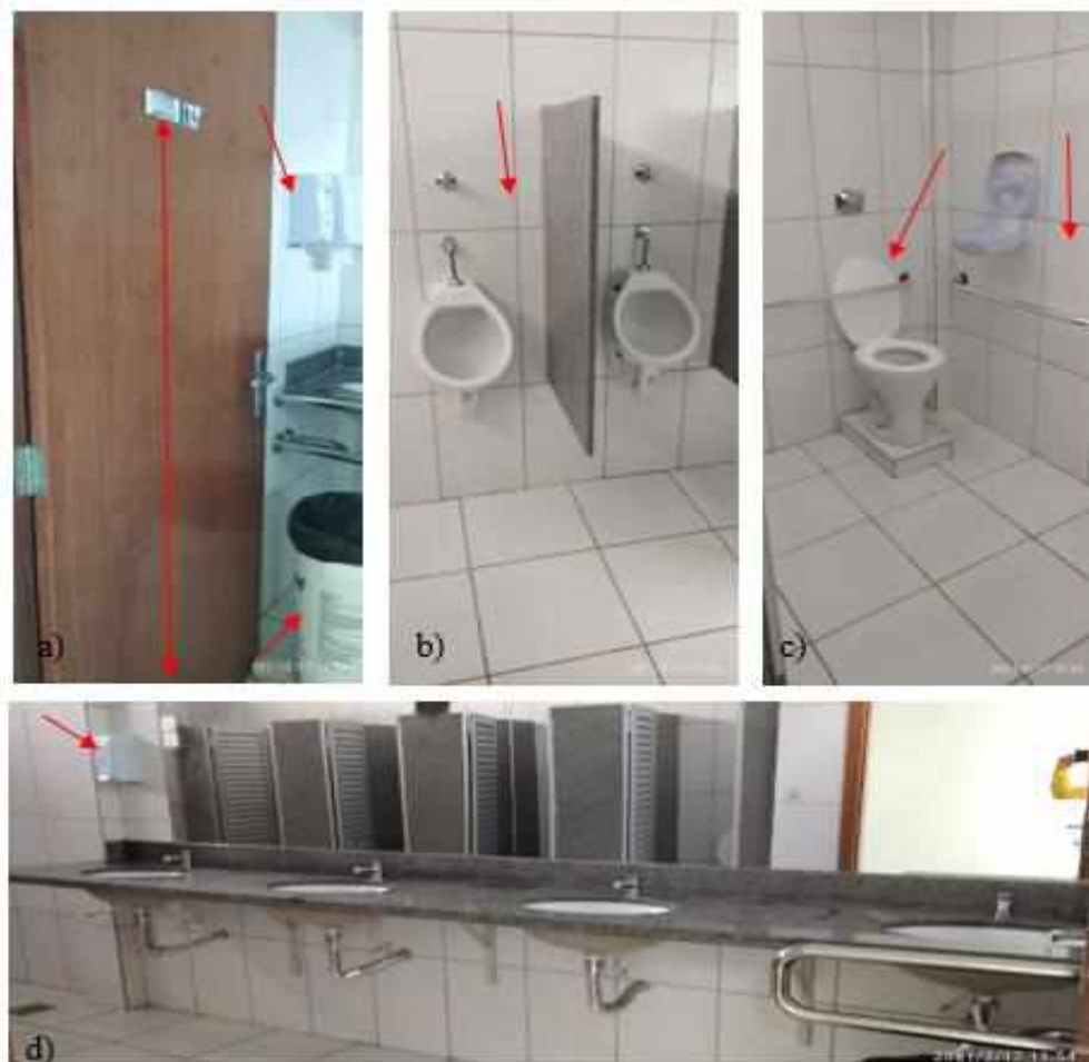
Figura 47 – Trecho D – Complexo de Laboratório de Nutrição – Banheiro Masculino
