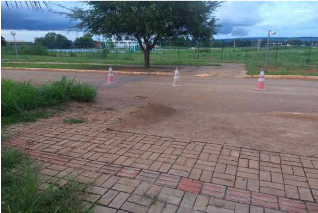
Figura 66 – Entrada principal do Câmpus Palmas: guia rebaixada e calçada
