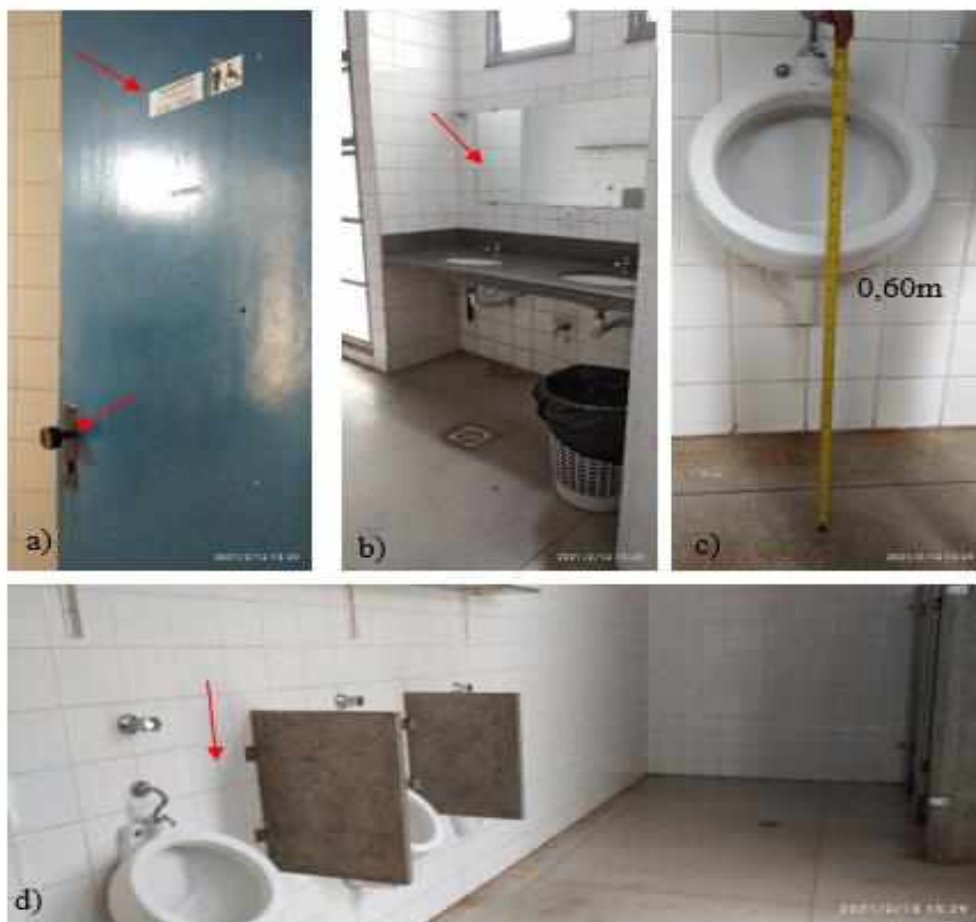
Figura 32 – Trecho C – Imagens do sanitário masculino do Bloco I, pavimento inferior
