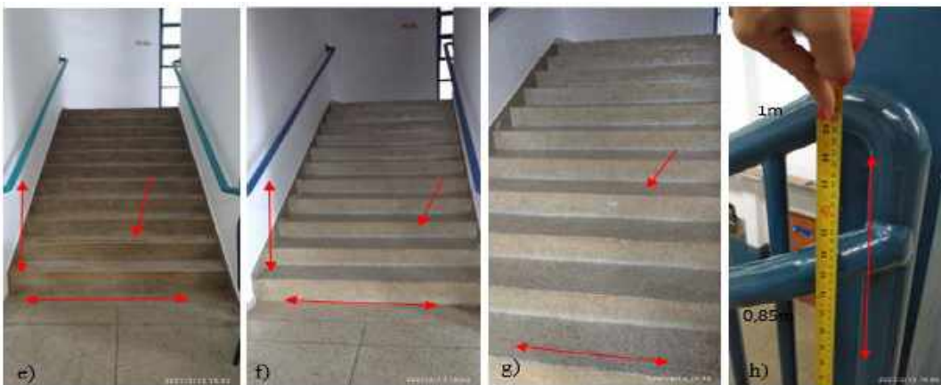
Figura 37 –Trecho C – Imagens das escadas dos Blocos II e III
