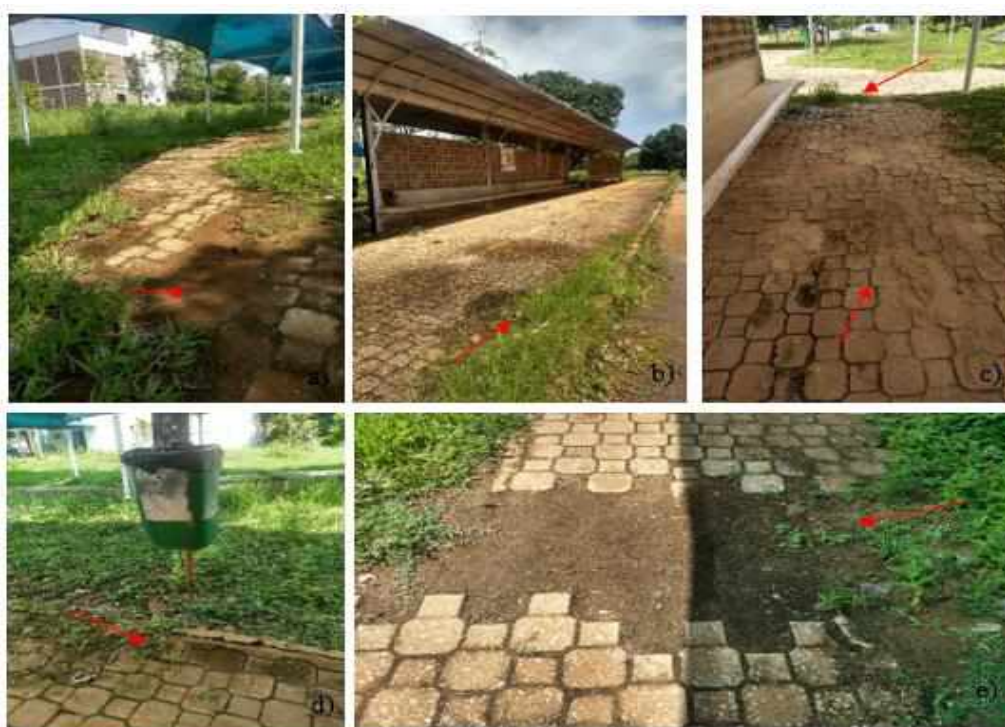
Figura 40 – Trecho C – Imagens das calçadas na proximidade da parada de ônibus do Bloco I
