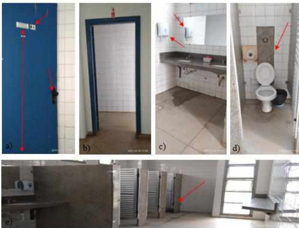
Figura 31 – Trecho C – Imagens dos sanitários femininos do Bloco I, pavimento inferior
