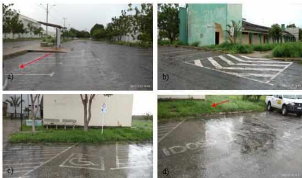
Figura 53 –Trecho B – Estacionamento Frente e Fundo do Bloco J
