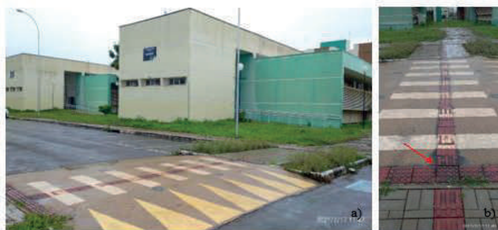
Figura 62 – Faixa de pedestre defronte ao Complexo do Laboratório de Nutrição
