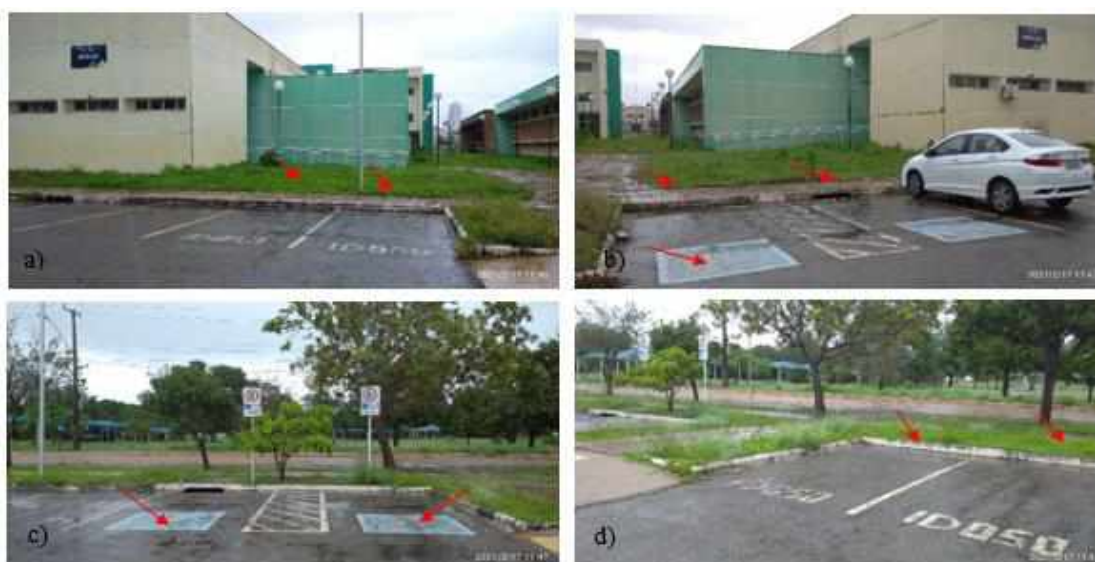
Figura 55 – Trecho D – Estacionamento do Complexo de Laboratório de Nutrição
