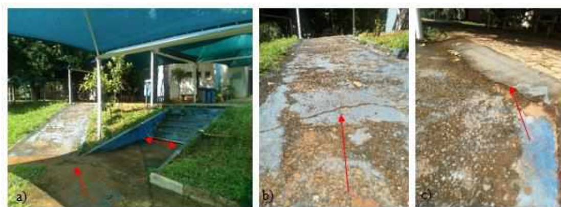
Figura 39 – Trecho C – Imagens da rampa que dá acesso à frente do Bloco I
