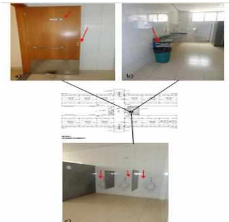
Figura 28 – Trecho B – Imagens do banheiro masculino
