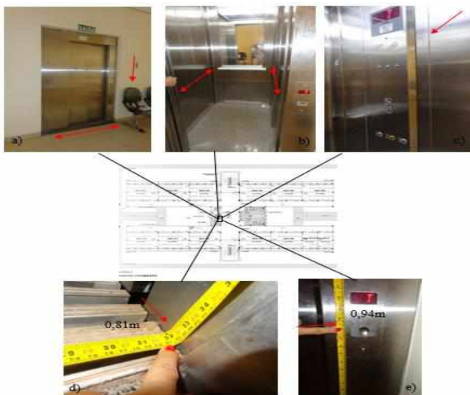
Figura 24 – Trecho B – Imagens de circulação interna (elevador):
