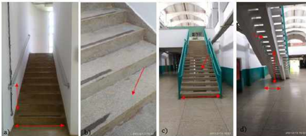
Figura 36 –Trecho C – Imagens das escadas dos Blocos I e II
