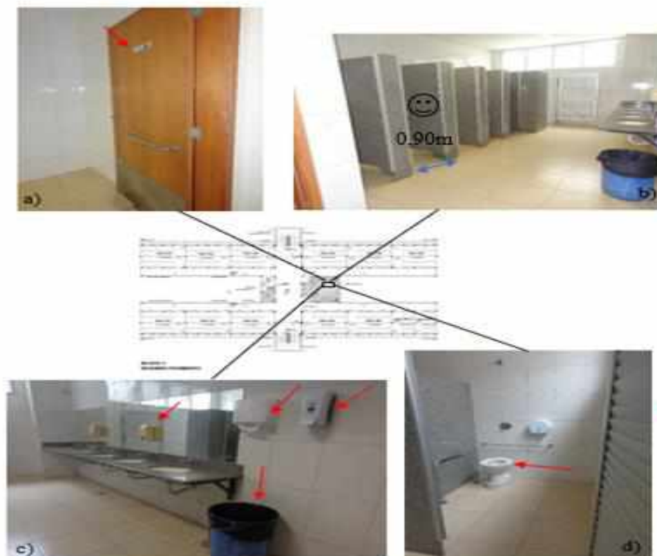
Figura 27 – Trecho B – Imagens do banheiro feminino
