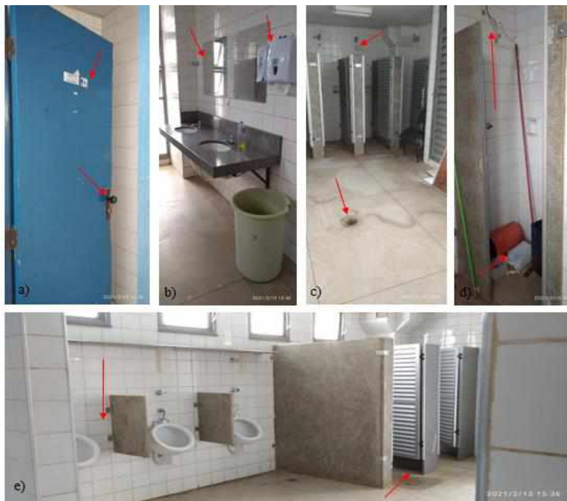
Figura 34 – Trecho C – Imagens do sanitário masculino do Bloco I, pavimento superior
