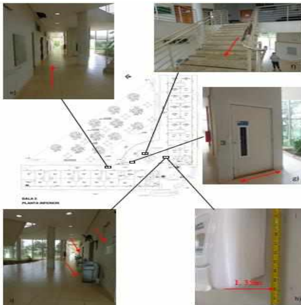
Figura 16 – Trecho A – Entrada ao edifício e circulação interna (Bala 2):
