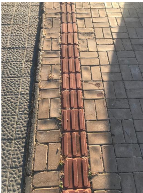
Figura 11 – Calçada com piso tátil e largura efetiva adequada
