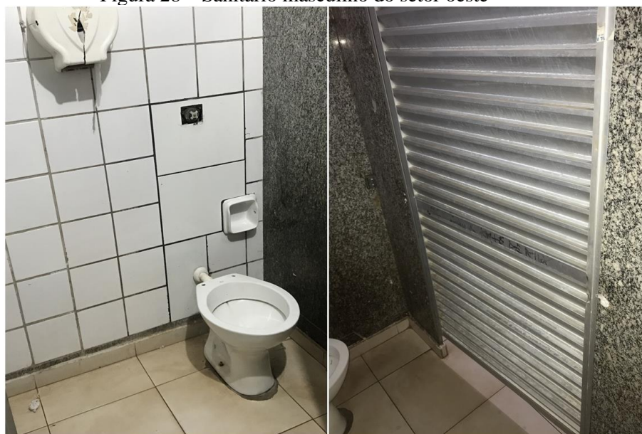
Figura 28 – Sanitário masculino do setor oeste
