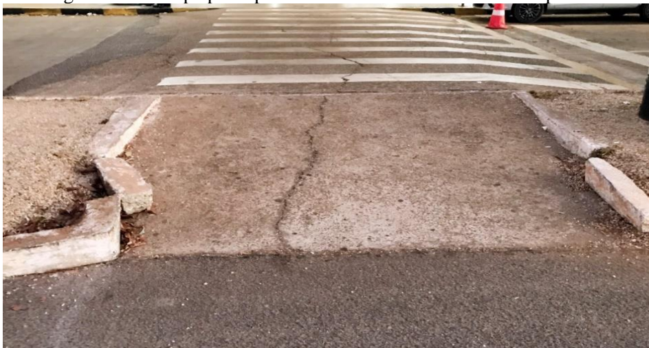
Figura 19 – Rampa principal de acesso ao terminal e faixa de pedestre
