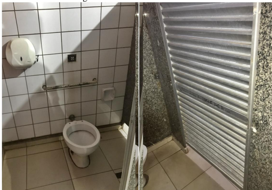
Figura 27 – Sanitário do setor leste
