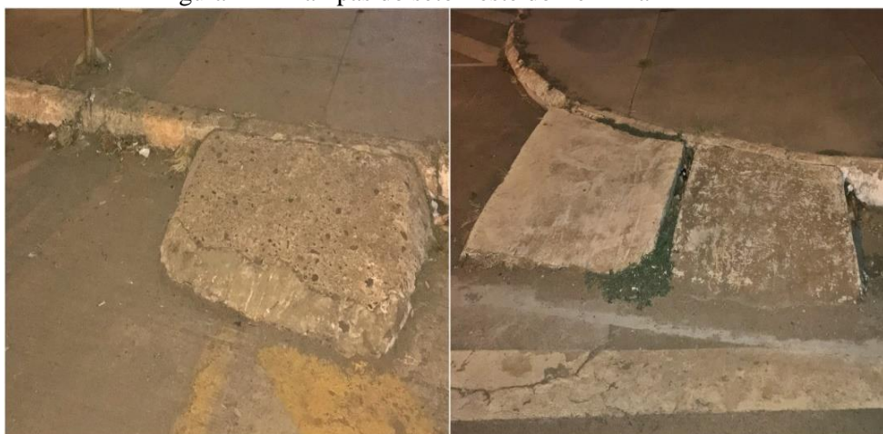
Figura 21 – Rampas do setor leste do Terminal
