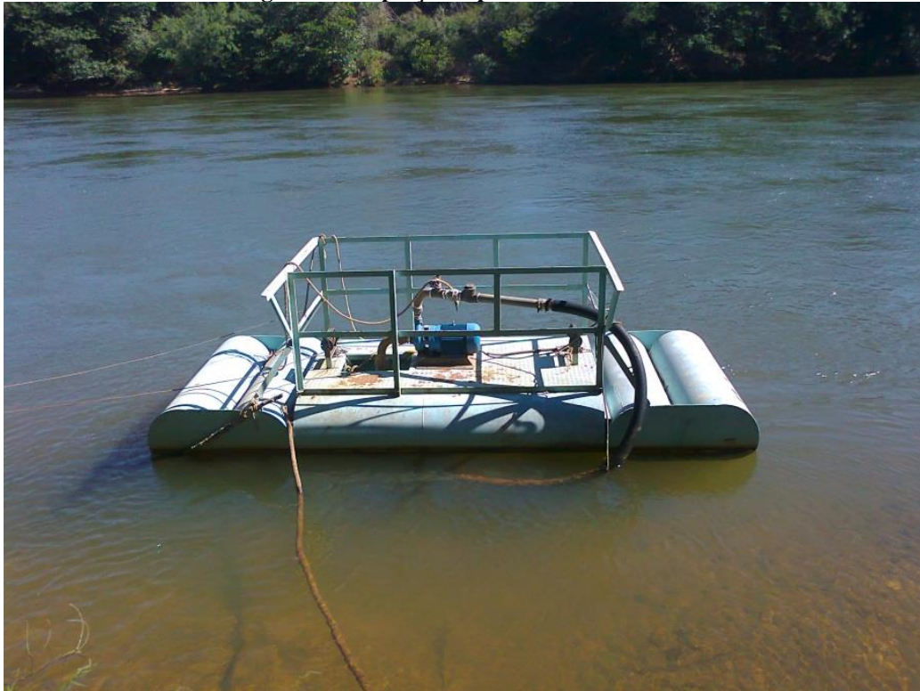
Figura 12: Captação superficial – Rio Sono
