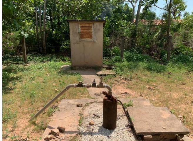
Figura 16: Poço tubular profundo utilizado na comunidade rural de Rio Sono
