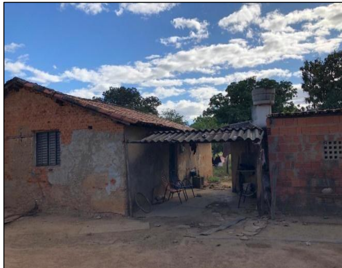
Figura 10 - Estrutura das casas na localidade Combinado R/2, alvenaria sem reboco.
