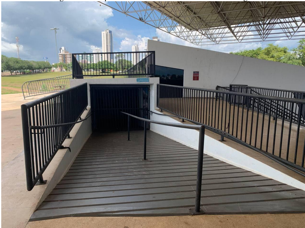
Figura 30- Rampa de Acesso ao Teatro Fernanda Montenegro
