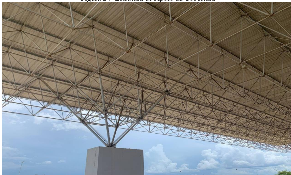
Figura 24- Estrutura de Apoio da Cobertura
