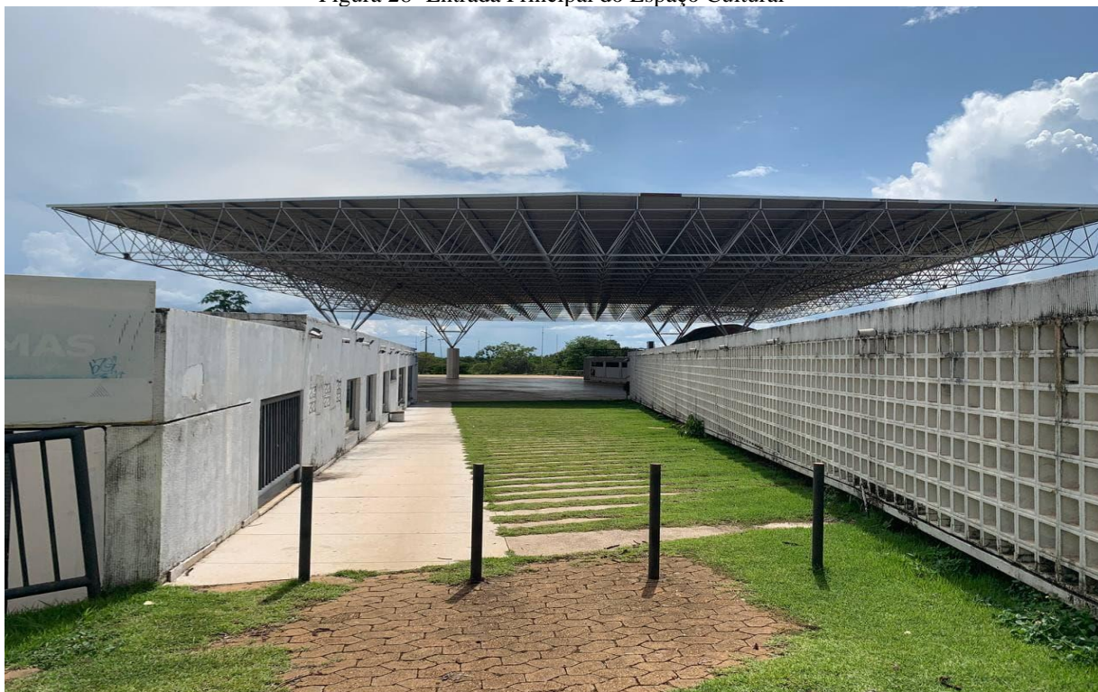
Figura 28- Entrada Principal do Espaço Cultural
