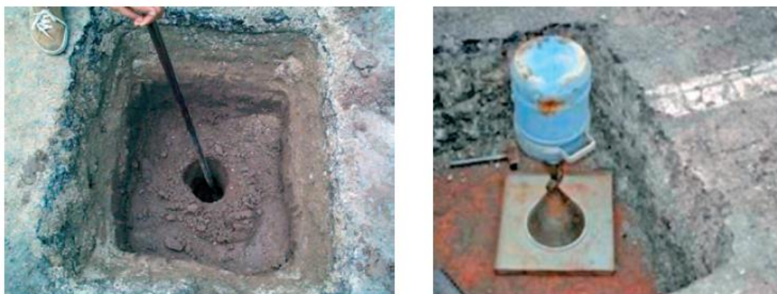
Figura 1: Método destrutivo de avaliação estrutural do pavimento
