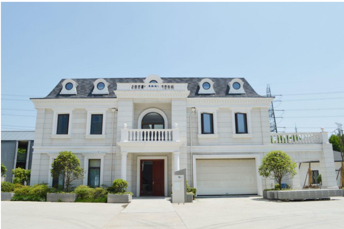
Figura 8 – Villa de Campo construída por impressão 3D pela Shanghai WinSun
