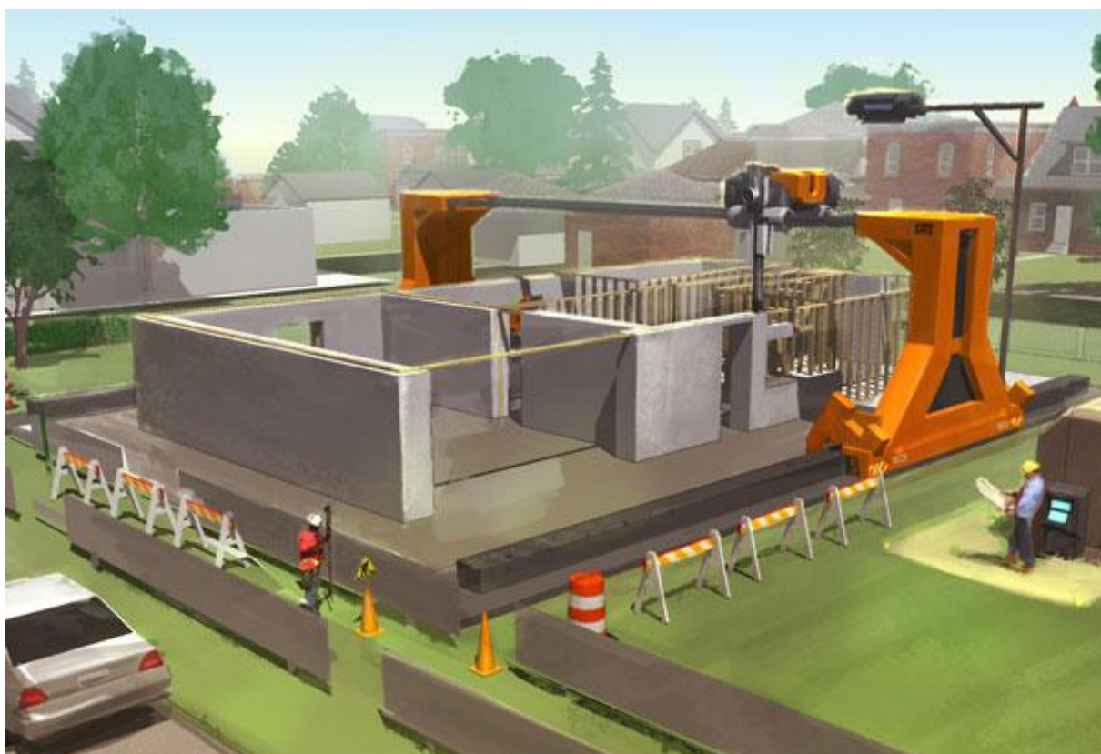
Figura 10 – Técnica de impressão 3D do tipo Contour
