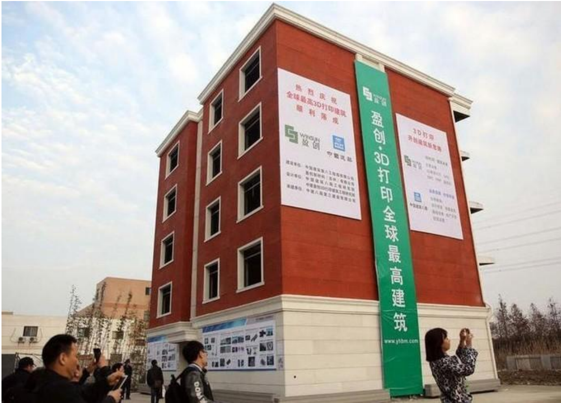
Figura 7 – Edifício de cinco andares feito por impressão 3D
