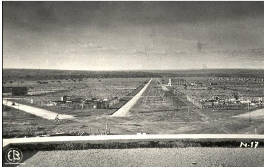
FIGURA 14 - AVENIDA GOIÁS E GRANDE HOTEL (1937) 120
