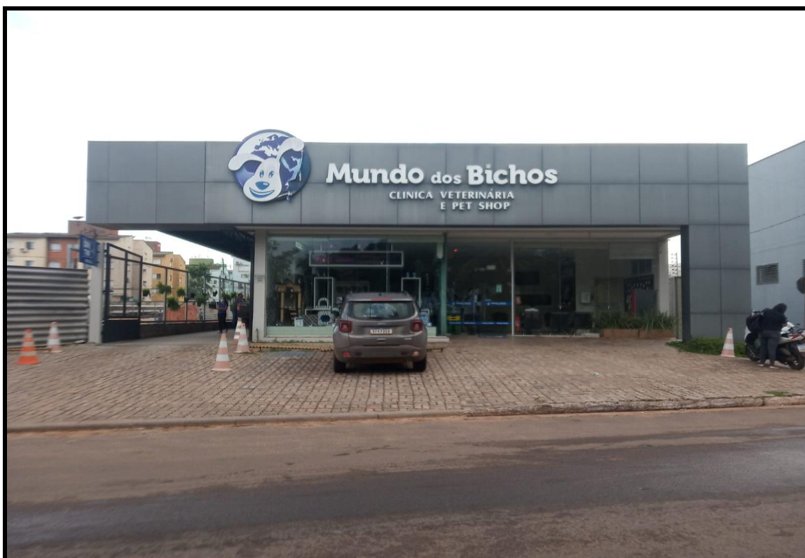
Figura 1 – Fachada da Clínica Veterinária Mundo dos Bichos, Araguaína-TO.
