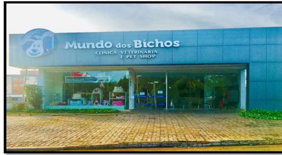
Figura 1. Fachada da Clínica Veterinária Mundo dos Bichos, Araguaína - TO
