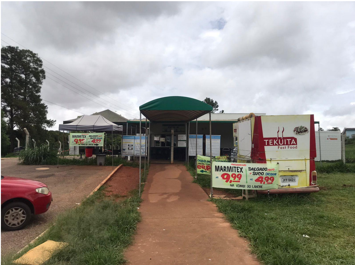
Figura 1: Fachada do Hospital Veterinário Público de Brasília.
