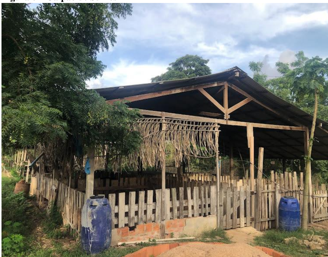
Figura 6 – Galpão de Suínos
