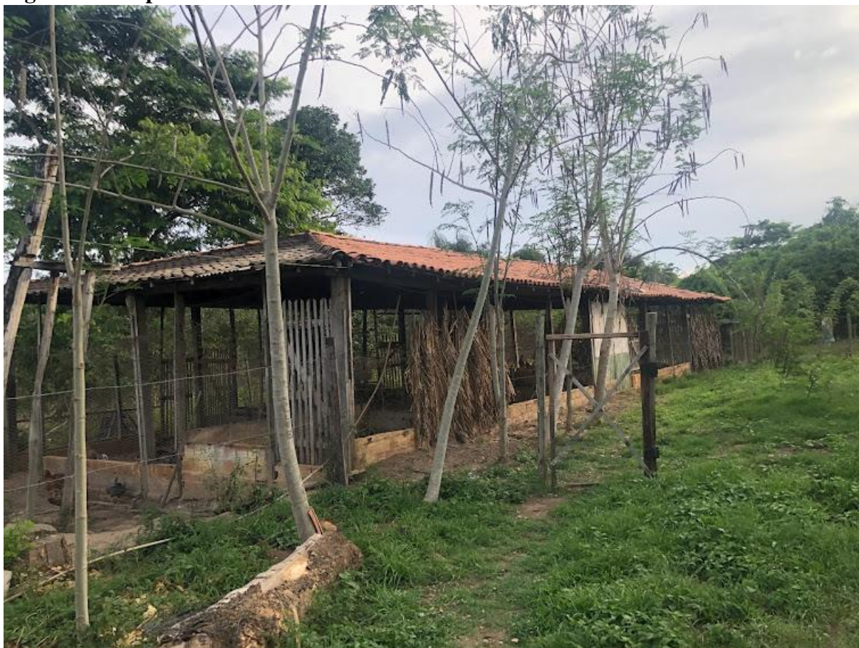
Figura 3 – Galpão de Aves
