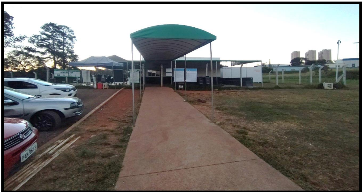
Figura 1: Fachada do Hospital Veterinário Público de Brasília.
