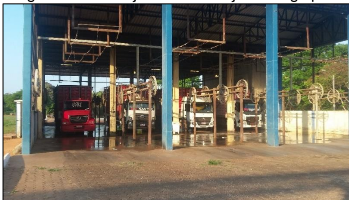
Figura 6 - Avaliação das condições do galpão.
