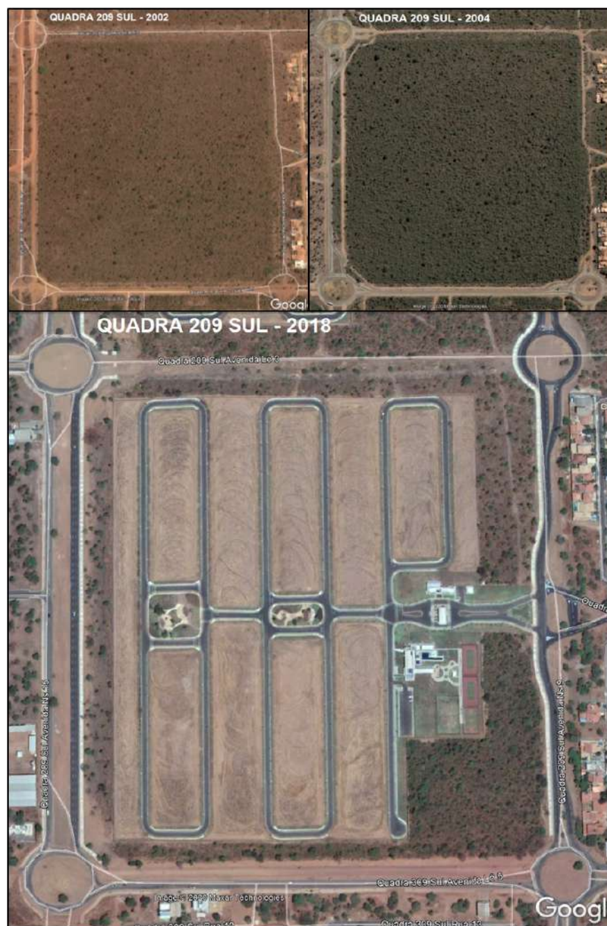
Figura 8 – Desenvolvimento urbano na quadra 209 Sul (ARSO 24) nos anos de 2002, 2004 e 2018
