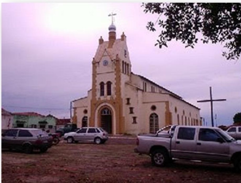
Figura 1 – Imagem da igreja matriz de Tocantinópolis.
