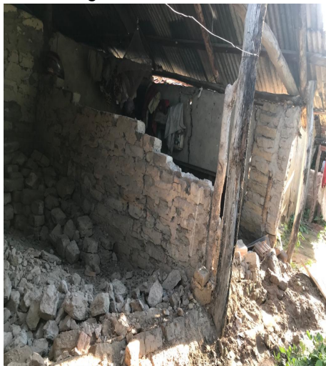
Imagem 19 - Parede caída
