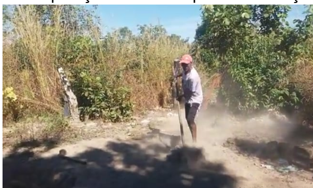
Imagem 09 - Preparação do terreno para a fabricação do adobe
