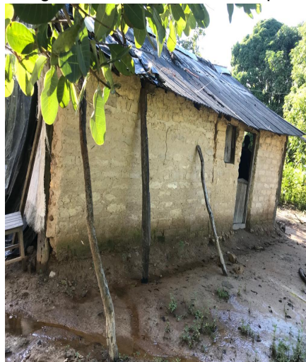
Imagem 20 - Escoras em uma parede
