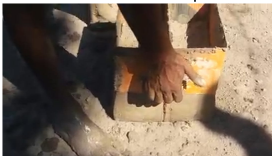
Imagem 15 - Removendo a forma que moldou o adobe
