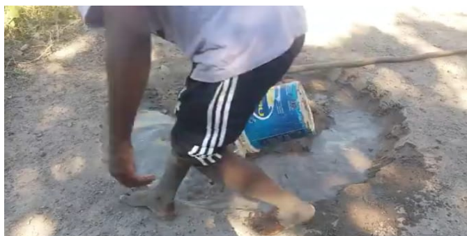
Imagem 11 - Misturando água na terra para transformá-la no barro
