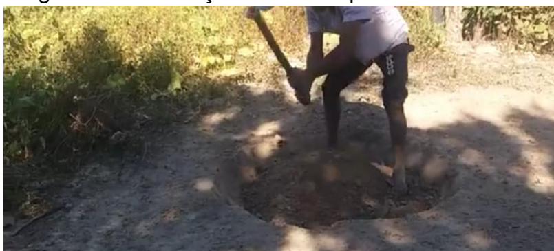
Imagem 10 - Escavação do buraco para retirado do barro
