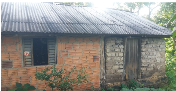
Imagem 05 - . Construção da Casa foi feita pelo Senhor Arraiano
