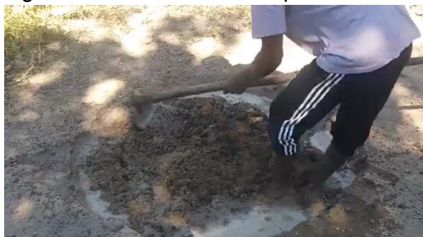
Imagem 12 -Misturado a terra para forma barro
