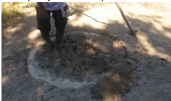
Imagem 13 - Preparação do barro para ser colocado na forma
