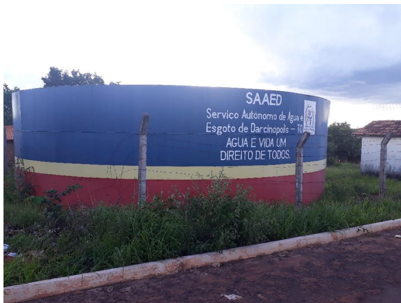
Figura 6- Caixa d'água em Darcinópolis (TO).
