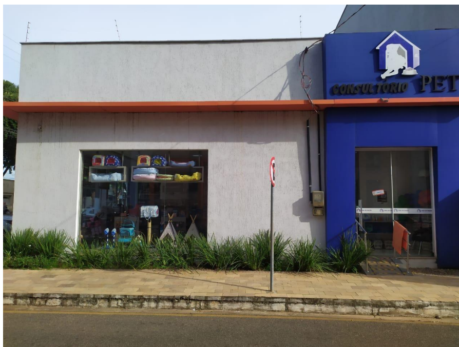
Figura 2. Fachada da empresa Casa da Ração. Entrada da clínica, Marabá-PA 2022.
