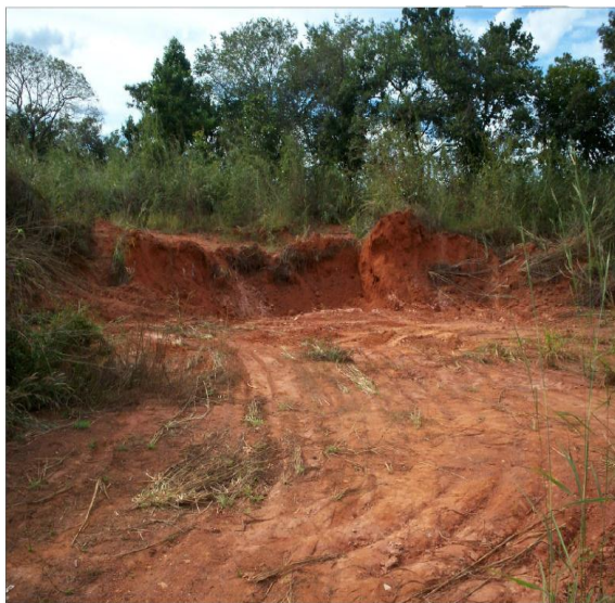
Foto 09: Início das obras para construção de vala impermeabilizada em Mutunópolis
