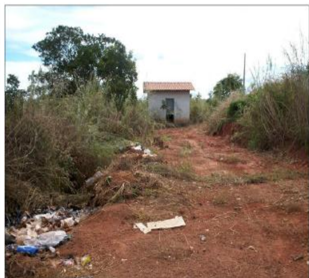
Foto 10: Guarita para controle de acesso ao local
