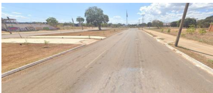
Figura 06 – Situação atual da travessia na rotatória próxima à UFT.
