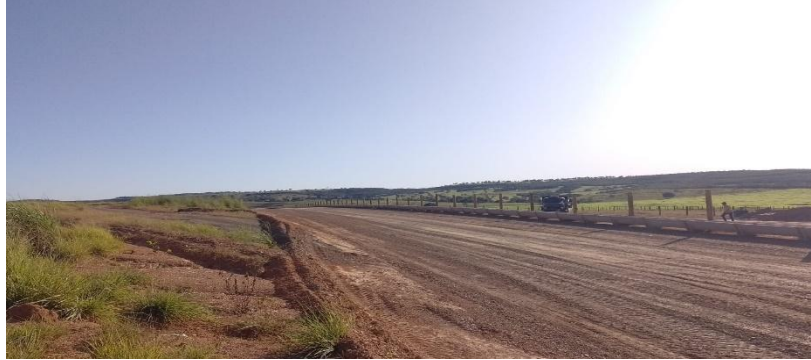
Figura 16- Materiais da cerca dos currais, com estacas em espaçamento de 4,5 metros
