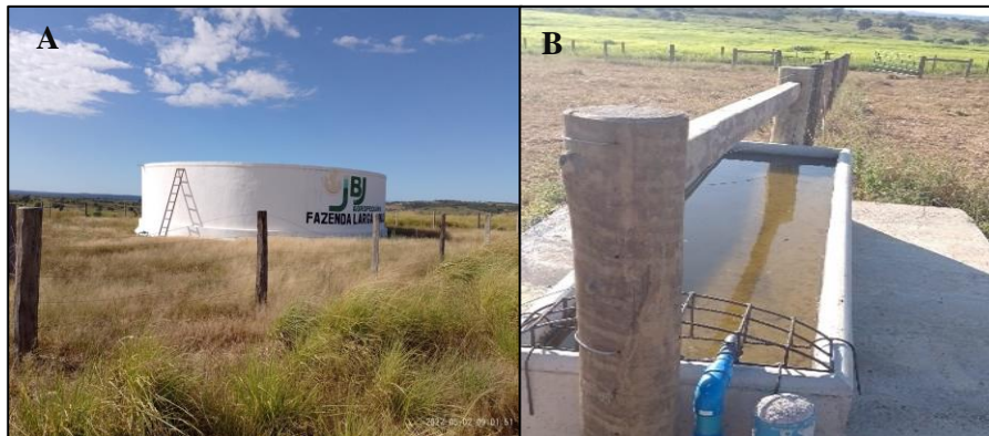
Figura 14 – Sistema de abastecimento hídrico. A) Caixa d’água do retiro Jenipapo; B) Bebedouro do curral do confinamento
