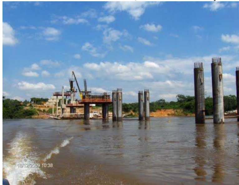
Foto 02. Vista da Ponte Zé Biel, durante sua construção.
