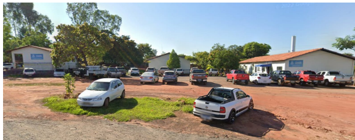
Figura 1. Fachada ADAPEC – Araguaína – Tocantins
