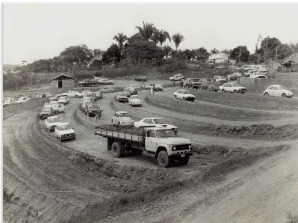
Figura 42 – Construção das rampas do ponto de apoio – 1989
