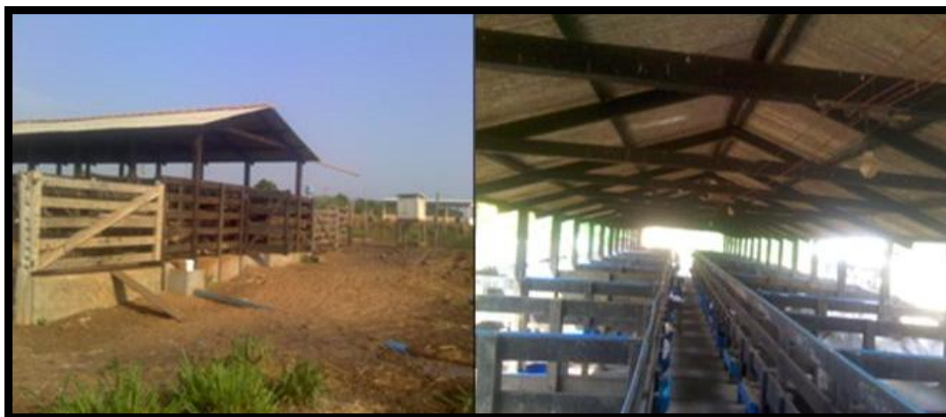
Figura 2.1 - Instalação sombreada – visão externa e visão interna da instalação.
