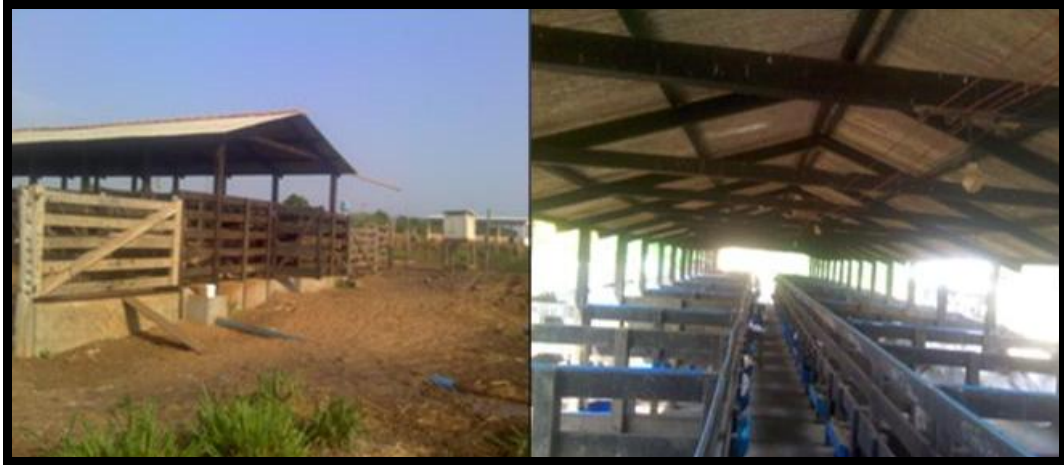
Figura 3.1 - Instalação sombreada – visão externa e visão interna da instalação.
