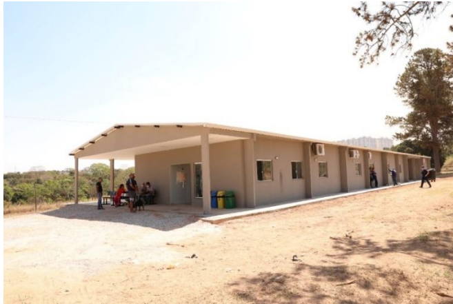
Figura 10. Fachada do prédio de Clínica Cirúrgica do HVEP
