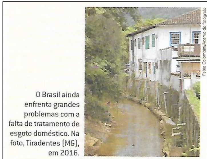
Poluição por esgoto doméstico sem tratamento.
