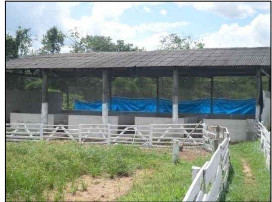
Figura 3. Galpão 2 para animais em fase de creche
