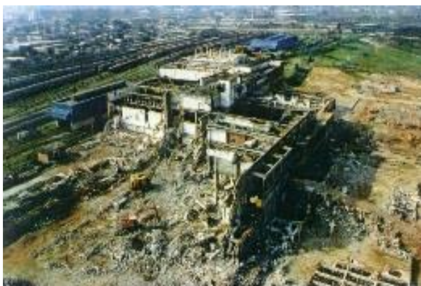
Figura 03 –Primeiro matadouro frigorífico do Brasil - Frigorífico Wilson desativado
