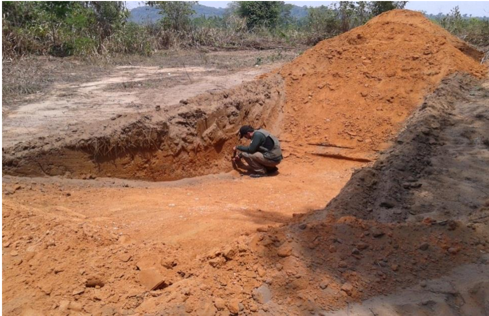
Figura 6 Servidor do Naturatins analisando o local da abertura da vala sanitária
