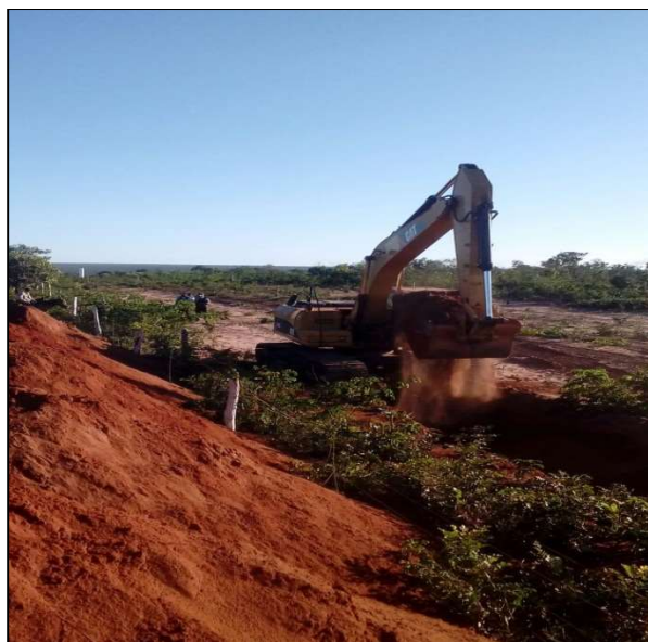
Figura 9: Máquina realizando a abertura de valas.
