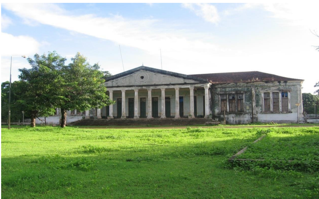
Figura 15 - Câmara Municipal de Bolama em ruínas.
