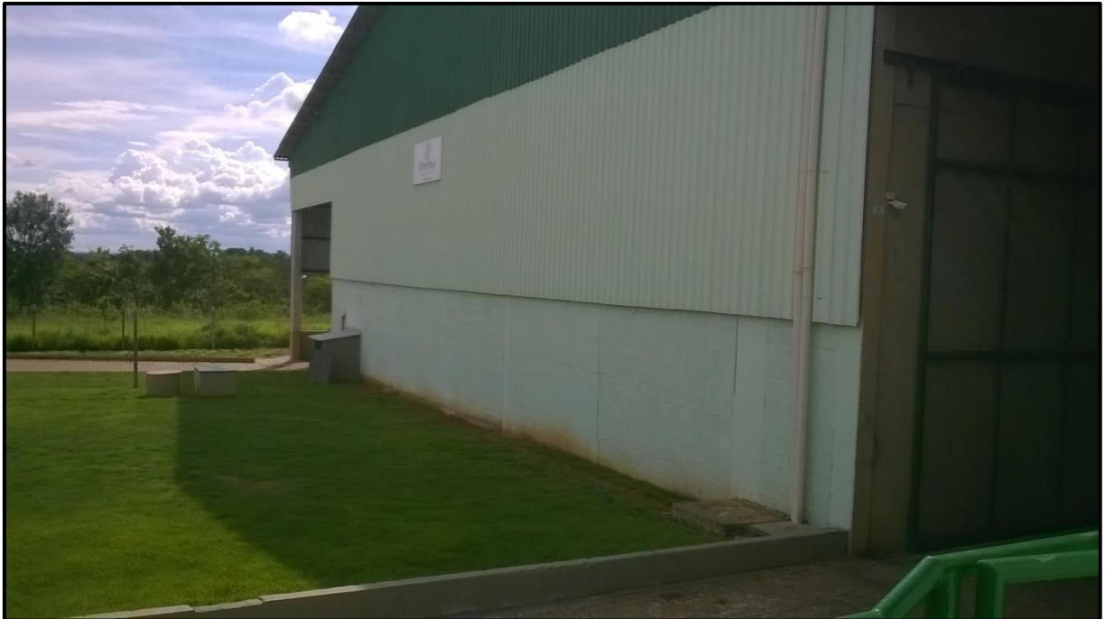
Figura 10 - Vista frontal do galpão de armazenamento da Terrafós, Araguaína-TO – Arquivo Pessoal (2016).
