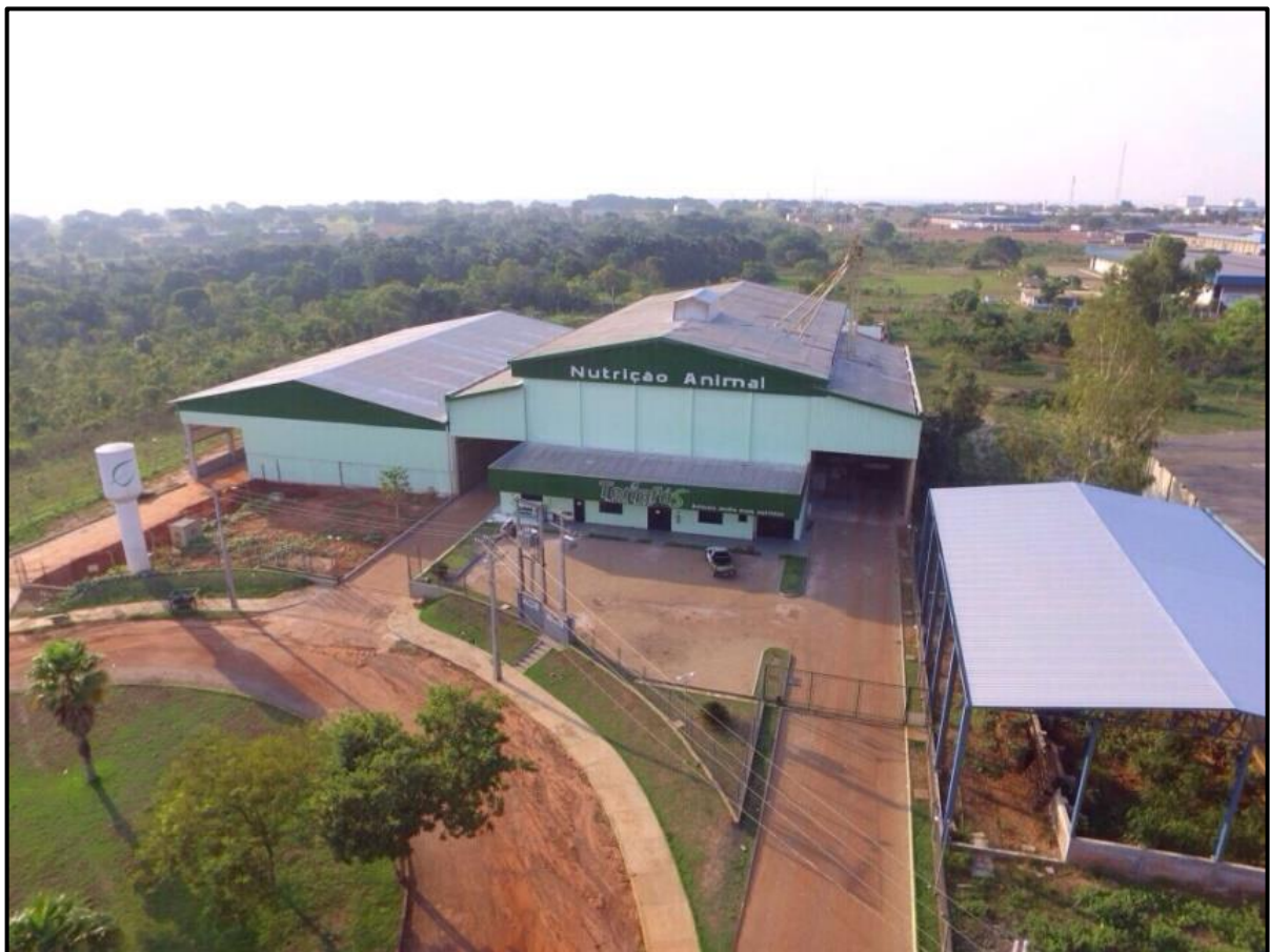
Figura 1 - Vista aérea da fábrica de ração da Terrafós, Araguaína-TO - Arquivo Terrafós (2016).
