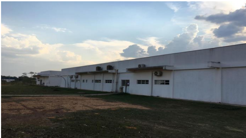
Figura 1. Vista parcial do Bloco B do Hospital Veterinário da Universidade Federal do Mato Grosso, Sinop-MT. Fonte: Arquivo pessoal, 2017.
