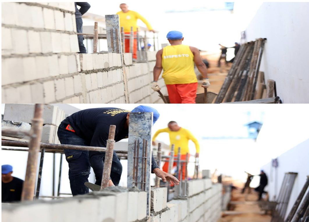
Figura 14 - Detentos auxiliando nas obras de reforma da UPRP
