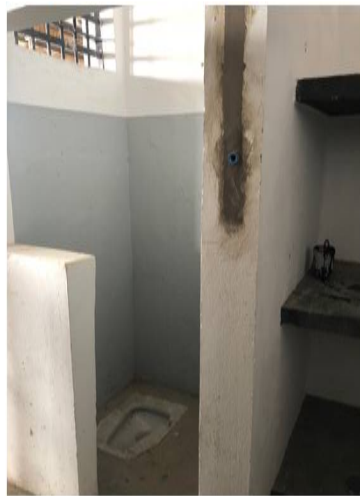
Figura 18 - Banheiro durante a reforma
