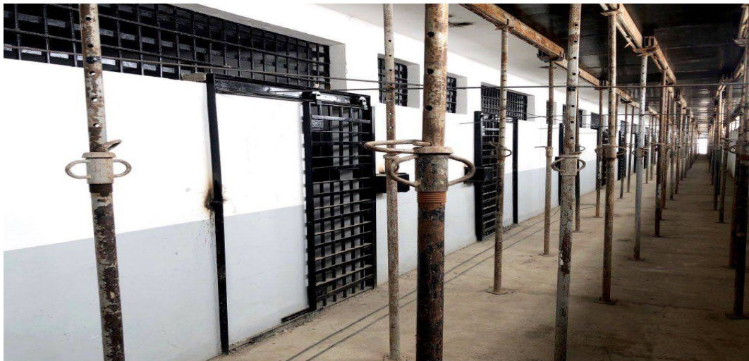
Figura 13 - Obras de ampliação dos pavilhões da UPRP
