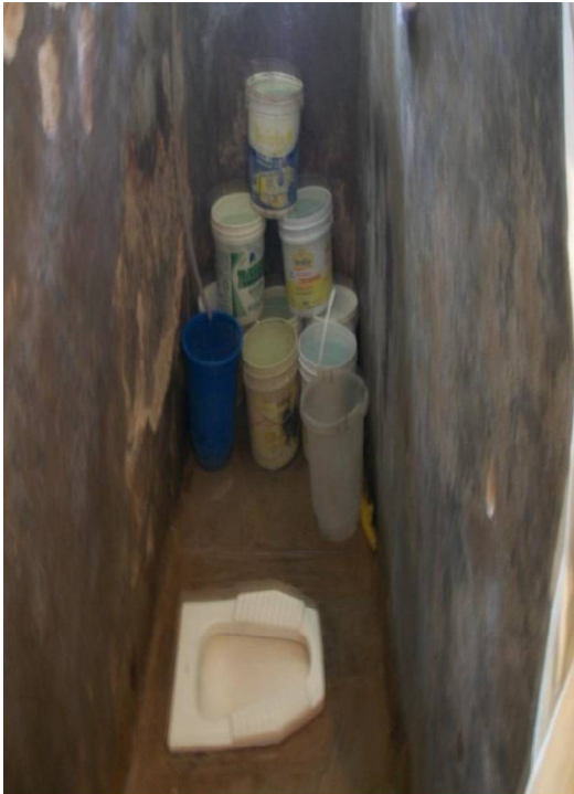
Figura 17 - Banheiro antes da reforma
