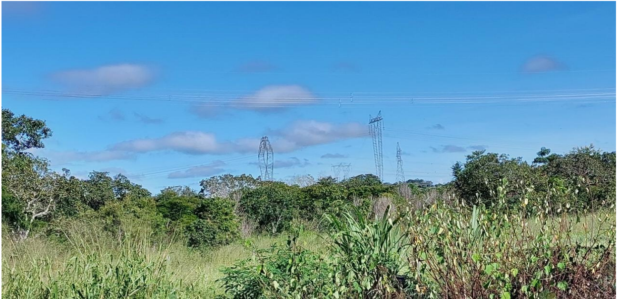
Figura 3 - Rede de alta tensão que cruzam o Reassentamento
