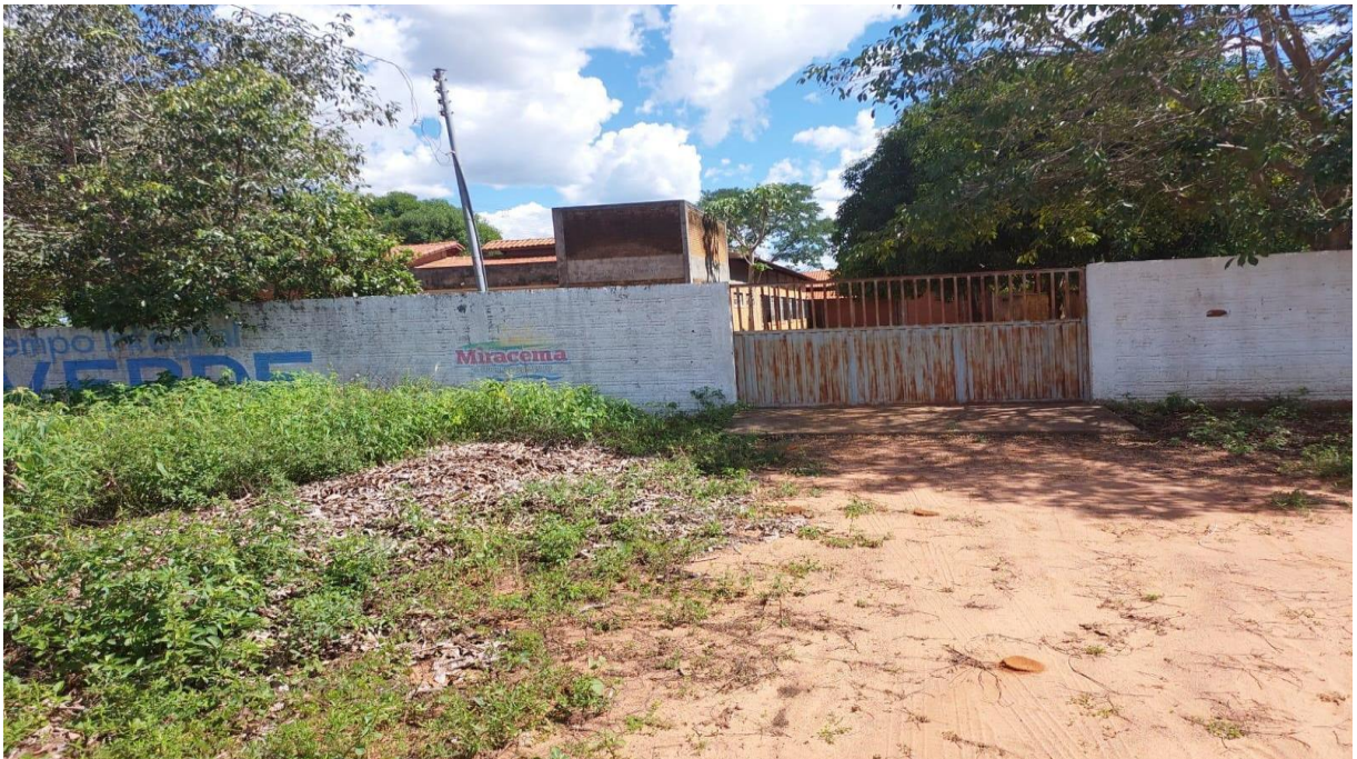
Figura 1 – Muro e fachada da EMTI Campo Verde
