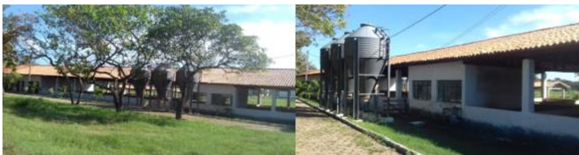
Figura 1: Visão externa da instalação.
