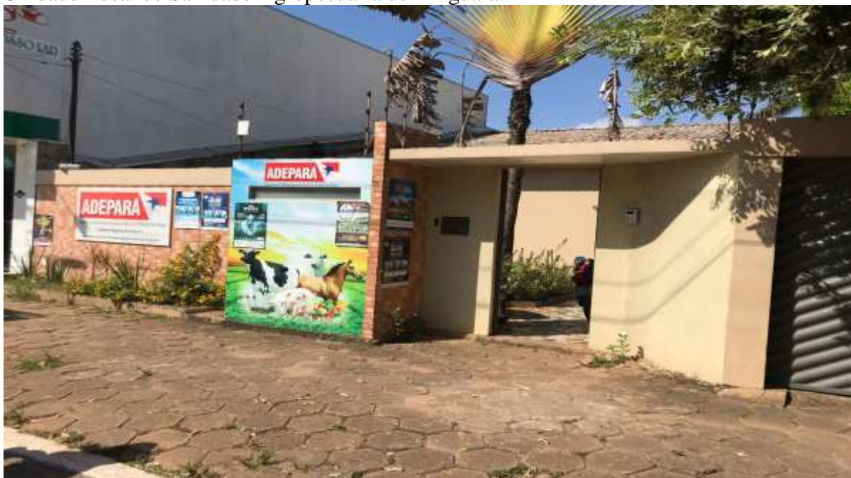
Figura 1 – Vista externa da Agência de Defesa Agropecuária do Estado do Pará (ADEPARÁ), Unidade Local de Sanidade Agropecuária de Xinguara.
