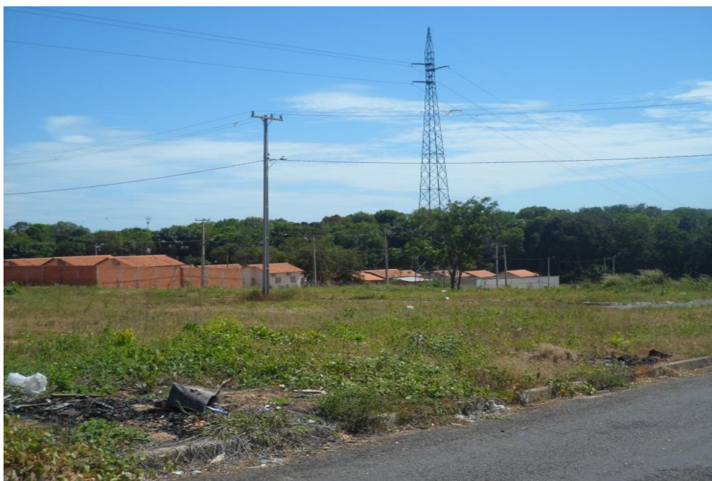
Fotografia 15: Rede de alta tensão cortando o Residencial Vila Azul em Araguaína – 2014
