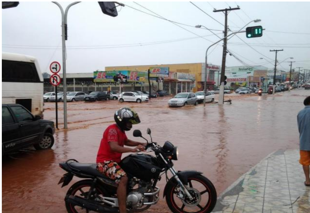
Fotografia 09: Avenida Cônego João Lima alagada em Araguaína - 2012
