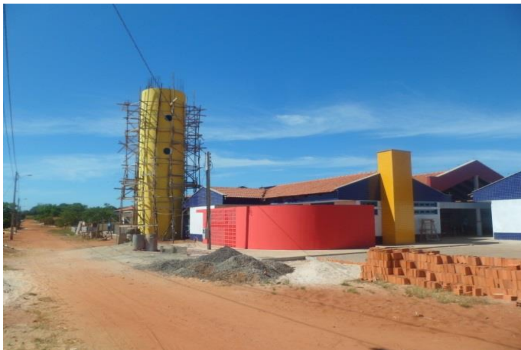
Fotografia 12: Creche em construção no Setor Monte Sinai – 2014
