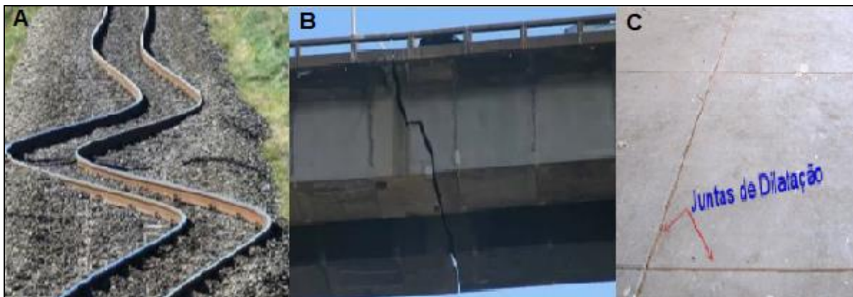
Figura 30: (a) Deformação devido à dilatação dos trilhos de trem, (b) junta de dilatação em uma ponte e (c) demonstra as juntas de dilatação em uma calçada.
