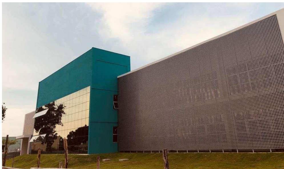
Figura 1 – prédio da biblioteca “Professor Severino Francisco”
