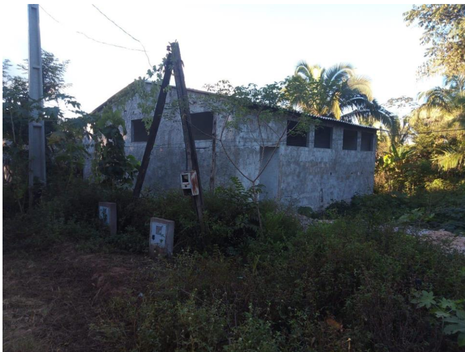
Figura 14 - Barracão em construção para extração dos subprodutos do coco babaçu na Comunidade Olho d'Água
