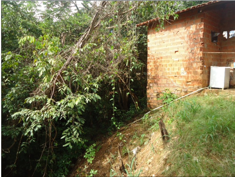
Figura 11 - Moradia na UC Machado em local de relevo acidentado
