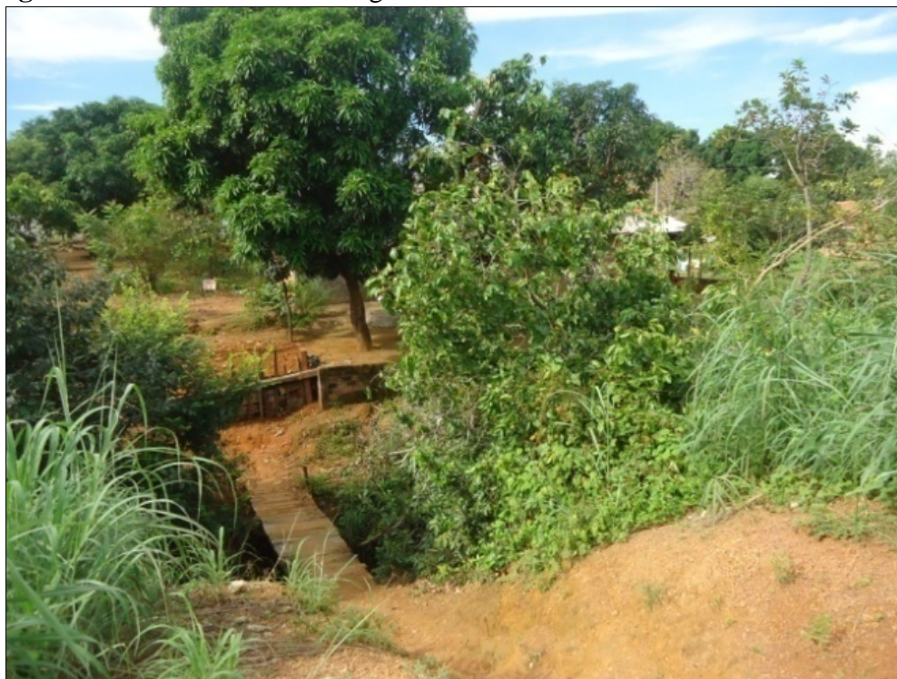
Figura 10 - Ponte sobre o Córrego Machado
