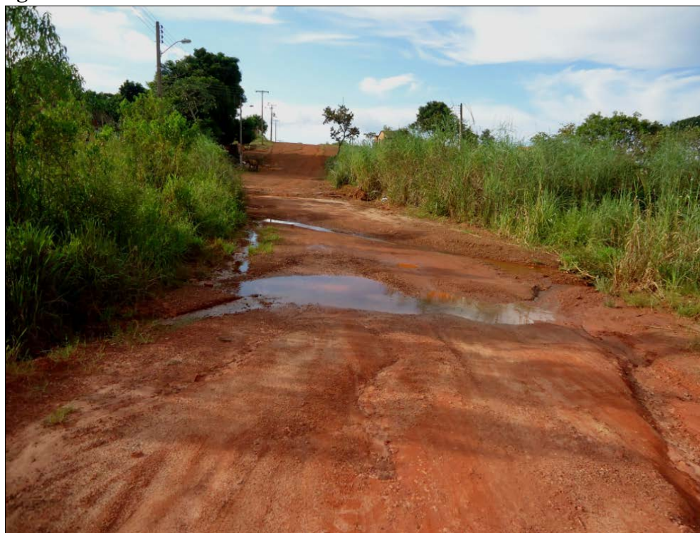
Figura 6 - Abertura de vias de acesso em áreas de nascentes
