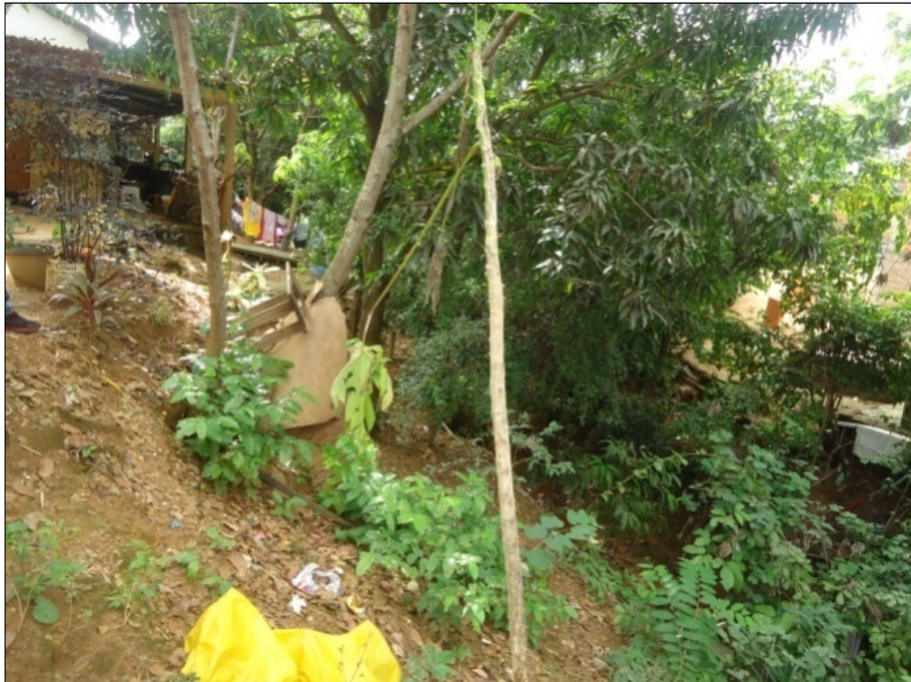
Figura 12 – Moradia na UC Machado com risco de desmoronamento
