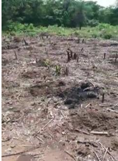
Figura 10- Preparo do terreno.
