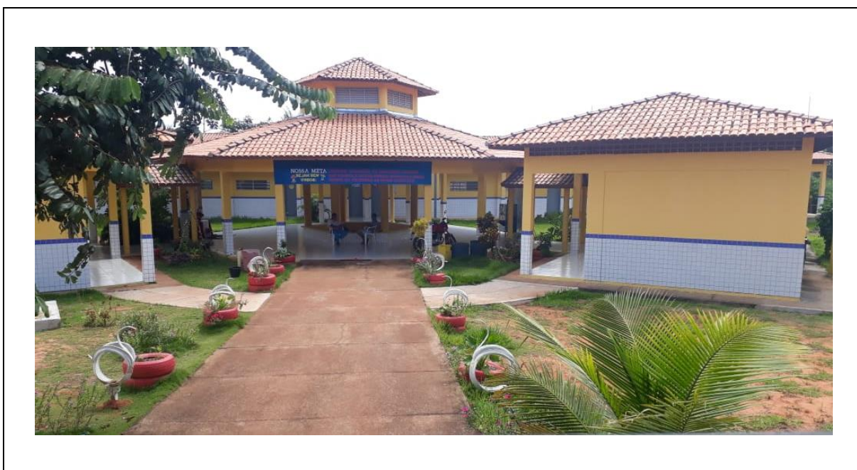
Figura 2. Escola Municipal Cândido Araújo, localizada na zona rural de Wanderlândia, TO.
